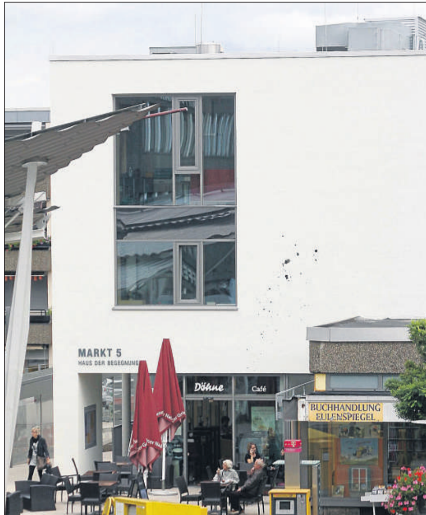
Haus der Begegnung: Das frisch sanierte Gebäude am Baunataler Marktplatz wurde im September 2014 mit einer Teermasse beworfen. Archivfotos: Kühlung
